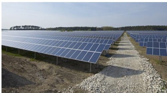
Abbildung 13 Typische Freifield-Installation, 2-reihig, portrait-Orientierung
